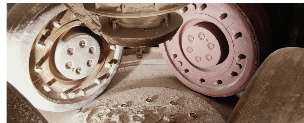
Mahlwalzen einer Vertikalmühle (Zementverarbeitung)
