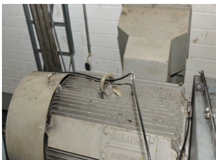
L'alimentation en graisse du moteur
