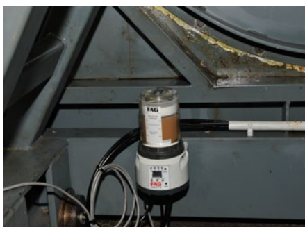
Le graisseur automatique CONCEPT8 FAG est monté directement sur le bâti du ventilateur
