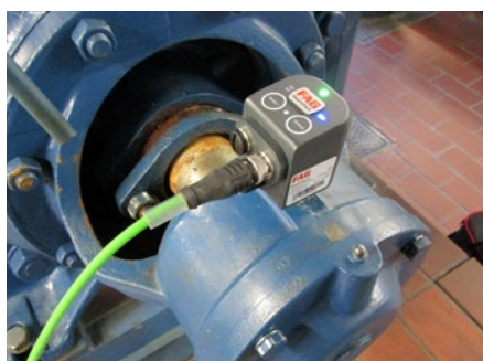
Les capteurs FAG SmartQB surveillent l'état des pompes
